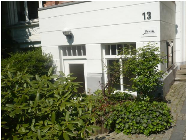
Eingangsbereich zur Gewerbefläche
