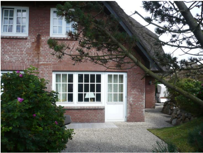
Blick auf die Süd-West-Terrasse auf das Wohnzimmer und das Schlafzimmer; Eingang rechts
